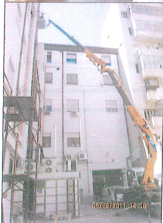
Congiunzione a impianto esistente mediante ausilio di gru mobile
